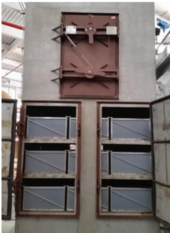
Freistehend installiertes GMCS nach dem Wäscher in einer Klärschlammverbrennungsanlage
