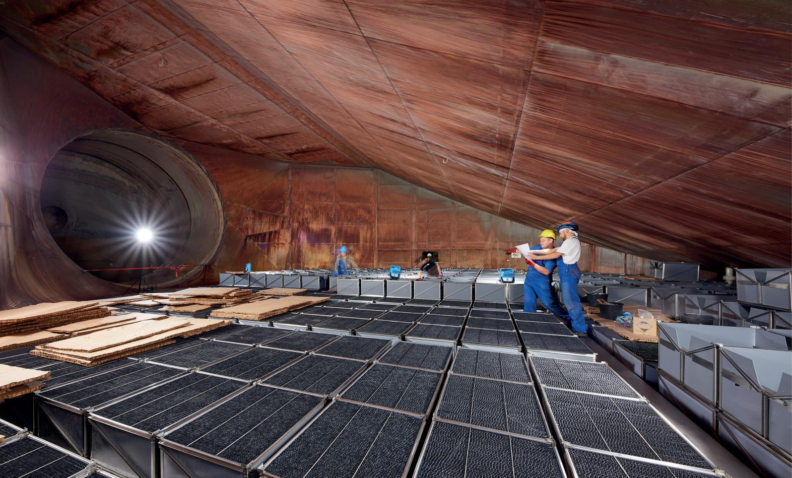
Im Heizkraftwerk Chemnitz Nord wurden 2018 zwei Lagen Module der US-amerikanischen Firma W. L. Gore eingebaut, die seitdem Quecksilber als auch Schwefeldioxid aus der Abluft entfernen. Foto: W. L. Gore
